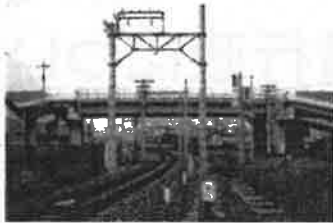
内谷陸橋(袴線橋)
