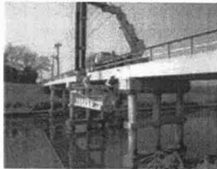
春日橋の点検の様子
